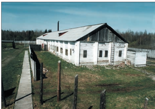
Рис. 2. Здание реставрированного лагерного штрафного барака 1946 г. постройки. Часть музейного комплекса «Пермь – 36» Пермская область
