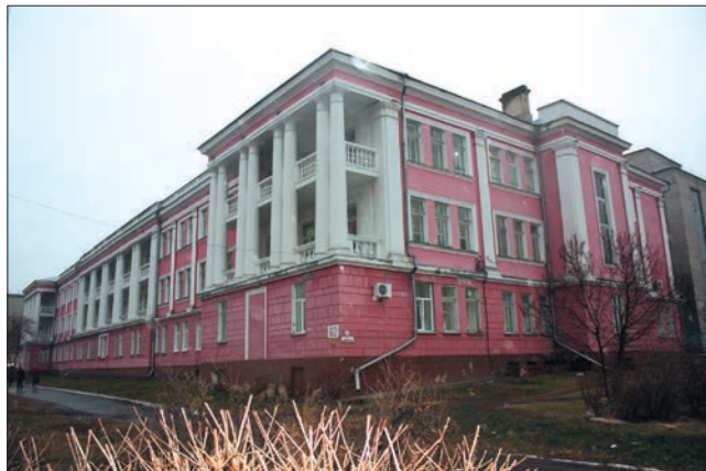
Рис. 1. Памятник истории и архитектуры «Хирургический корпус городской больницы, где работал А.Н. Чеглецов – хирург, заслуженный врач РСФСР, первый в крае сделавший операцию на сердце» 1939 г.
